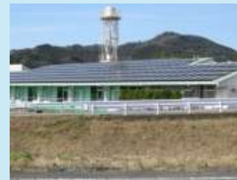
図1（太陽光発電全景）
